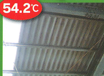
未施工部屋根の裏面温度
