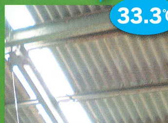
遮熱塗装部屋根の裏面温度
